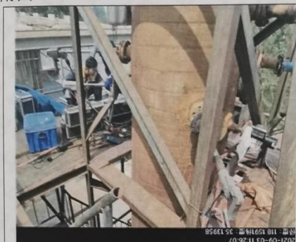
附图1 焚烧炉废气采样现场
