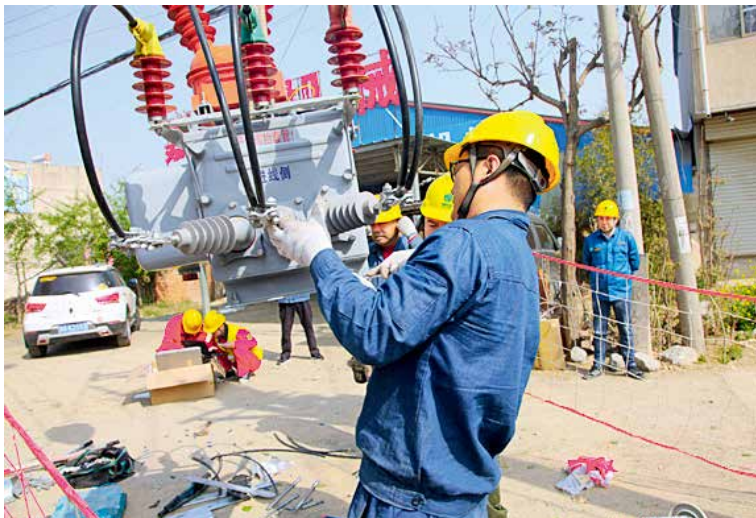
施工人员对义堂八线进行升级改造
