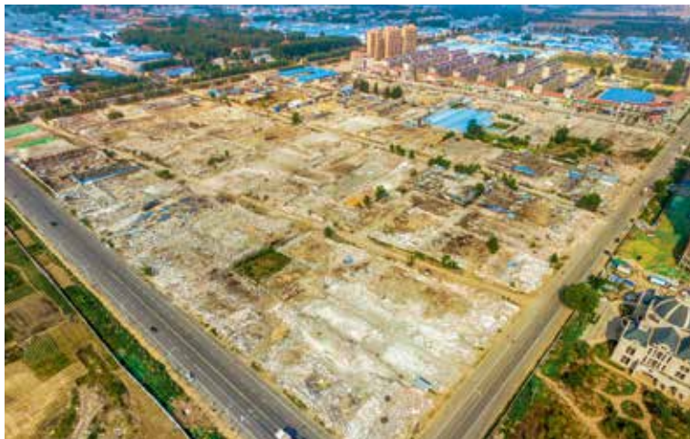
中央公园北片区拆迁现场
