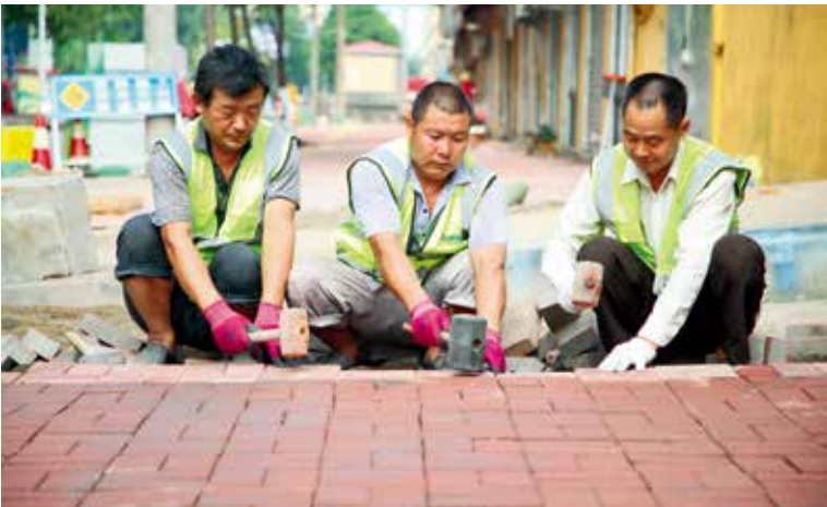
人行道板铺装
